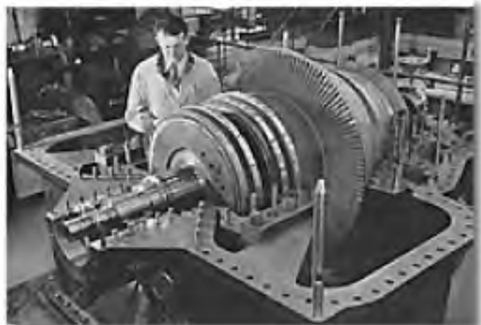
یک توربین بخار برای استفاده در کشتی
